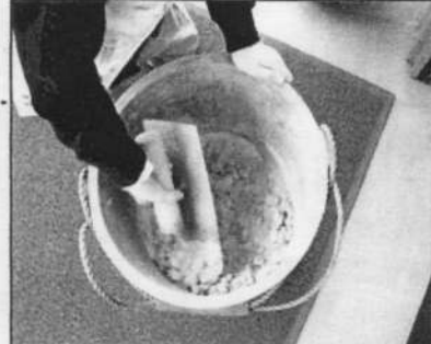
粉状の珪藻土に水を加え混ぜます
