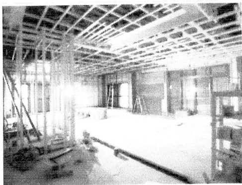
床の下地張りや、水周りの工事などが進行中。
